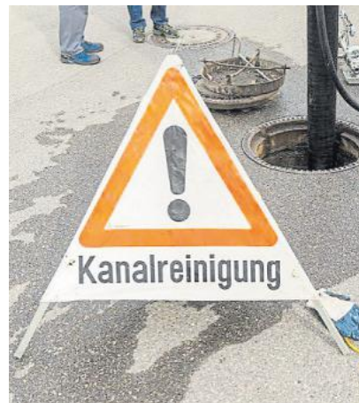
Am Montag beginnen in Heide die Arbeiten für die Regelspülung. Foto: AZV
