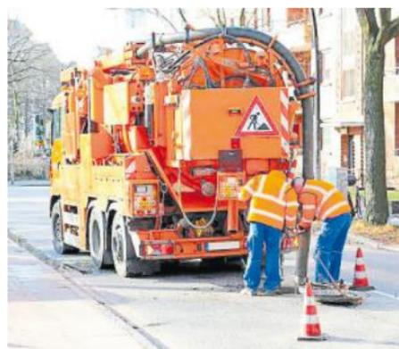
Mit einem solchen Spezialfahrzeug wird das unterirdische Leitungsnetz gereinigt.
