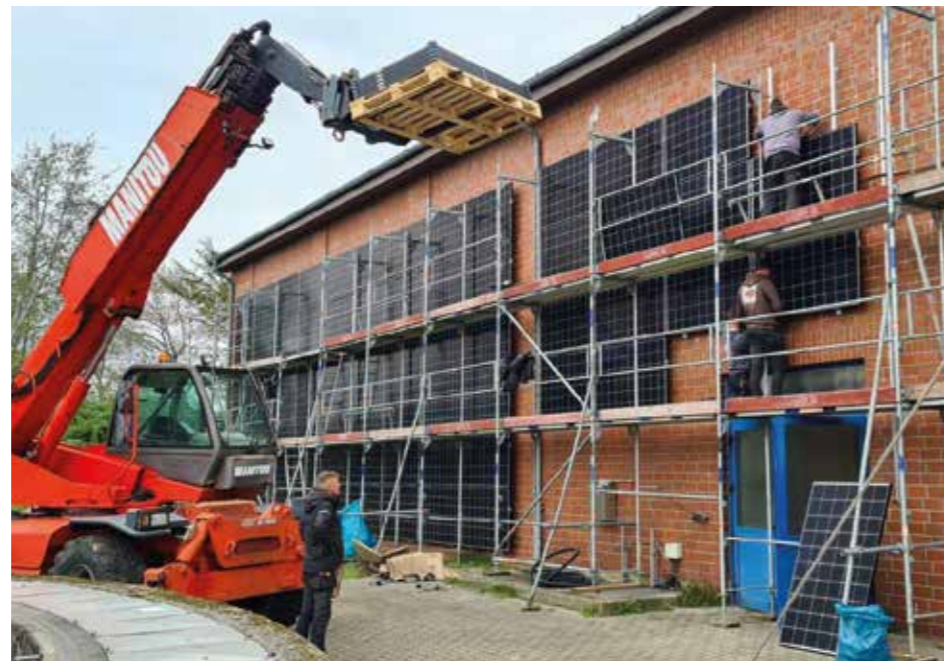
Die Module der Photovoltaikanlage am Filtrationsgebäude werden montiert.
