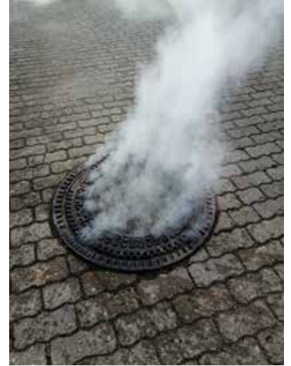
Überprüfung der Leitungsverläufe durch Nebelung
