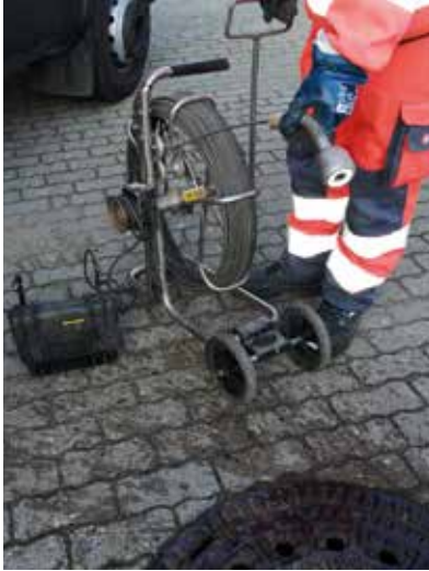
Überprüfung der Leitungen durch ein Kamerasystem
