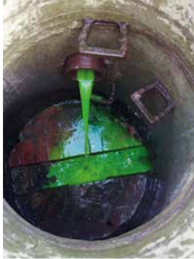
Überprüfung der Leitungen mittels Farbttest
