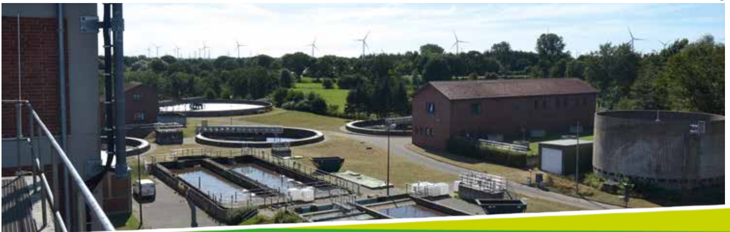
Das Heider Klärwerk am Friesenweg
