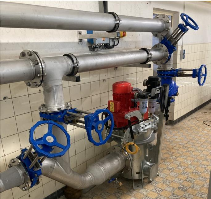
Mittlerweile wurde der Mazerator (kleines Foto oben) auf der Kläranlage Heide in Betrieb genommen. Somit sollten die unliebsamen Verzopfungen (Verklebungen von Haaren und anderen Feststoffen im Klärschlamm) im Faul-turm der Vergangenheit angehören.
