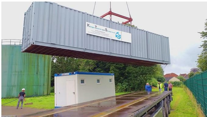
Eine Containerlösung stellte auch während der Arbeiten einen Betrieb mit zumindest verringerter Leistung sicher. Der logistische Aufwand hierfür war enorm. Die beengten räumlichen Gegebenheiten erforderten den Einsatz eines Mobilkrans mit großem Ausleger (Foto).
